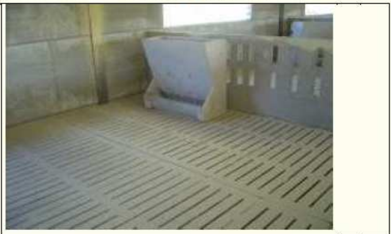
VALLAS, REJILLAS Y TOLVAS DE HORMIGÓN PARA CEBADERO
