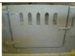
Puertas en Hormigón
