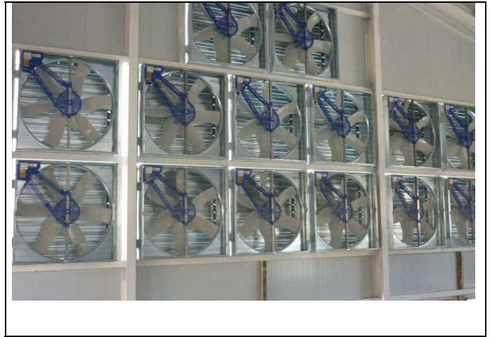
DETALLE DE LOS VENTILADORES PARA TIPO TUNEL
