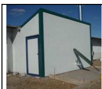
Caseta Exterior para Generador
